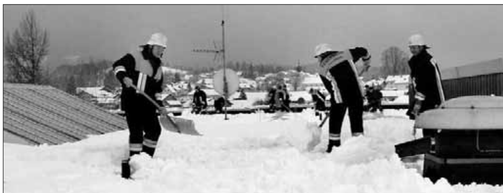
Gestern Nachmittag in Ruhmannsfelden: Feuerwehrleute räumen die tonnenschwere Schneelast auf den Schuldächern.
